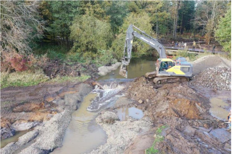
Das neue Flussbett erstreckt sich im Wiesenbereich parallel zum Altlauf (oben im Bild). Innerhalb des gestreckten Verlaufs (hier im Bauzustand) schlängelt sich die Ise deutlich strukturreicher, als es im Altlauf der Fall war.
