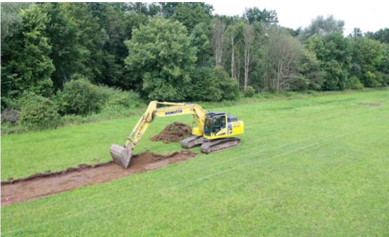
Die strukturarme Ise (links) wurde im Betzhorner Leu durch die Firma Mittelweser Tiefbau in ein neues, strukturreiches Gewässerbett verlegt. Hierzu wurde auf einem angrenzenden Wiesenbereich (Mitte) und durch den Forst (rechts) ein neues Flussbett angelegt, wo sich die Ise zukünftig eigendynamisch entwickeln kann.
