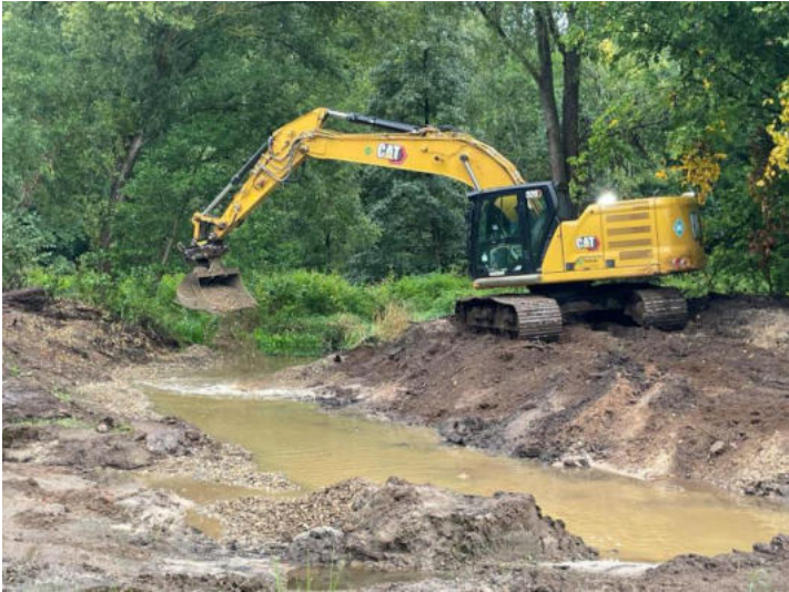
Das neue Flussbett erstreckt sich im Wiesenbereich parallel zum Altlauf (oben im Bild). Innerhalb des gestreckten Verlaufs (hier im Bauzustand) schlängelt sich die Ise deutlich strukturreicher, als es im Altlauf der Fall war.
